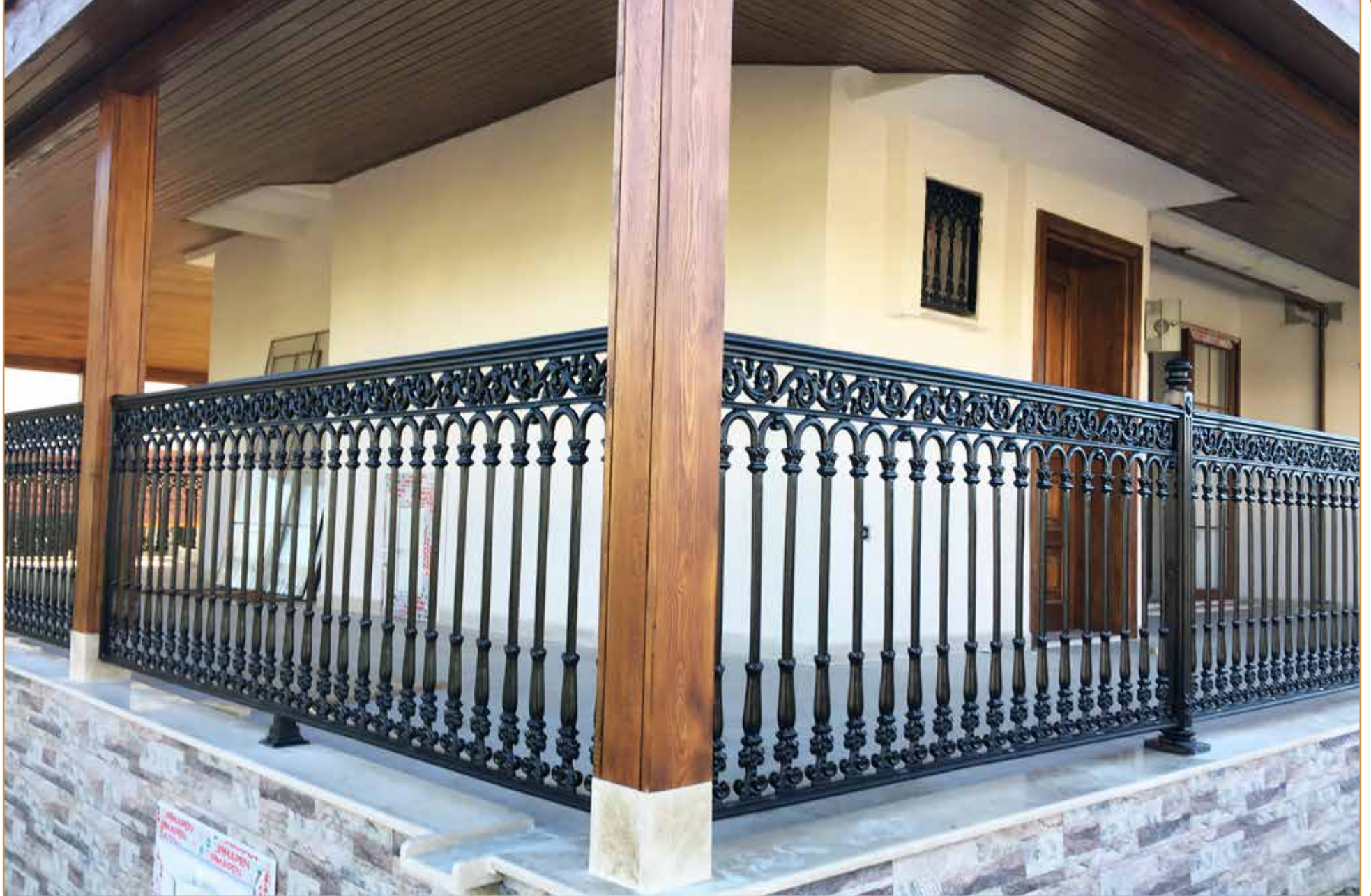
Villa Balkon Uygulaması Datça / Muğla
