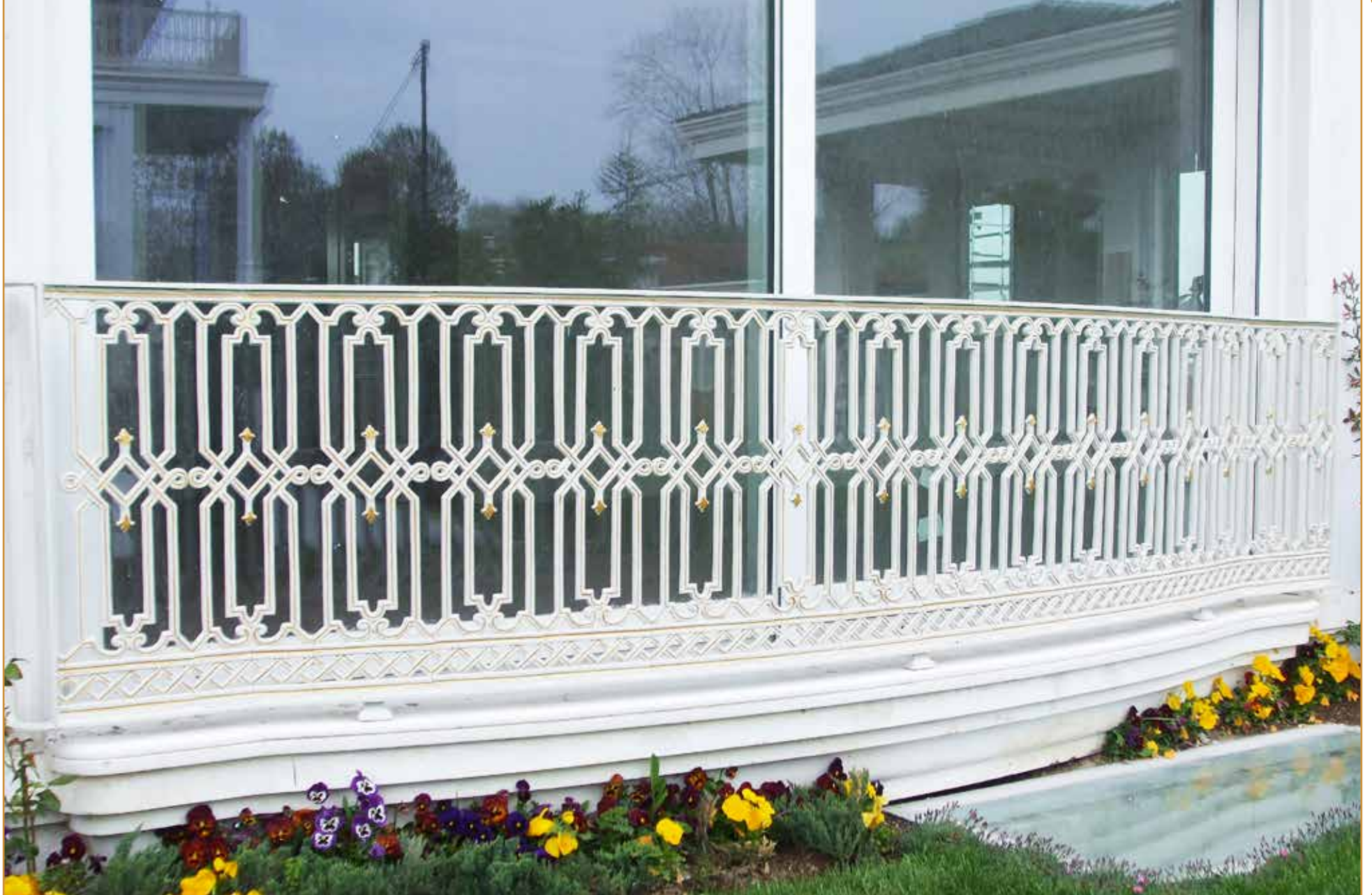
Şahinler Giyim Villa Balkon Korkuluk Uygulaması Kemerburgaz / İstanbul
