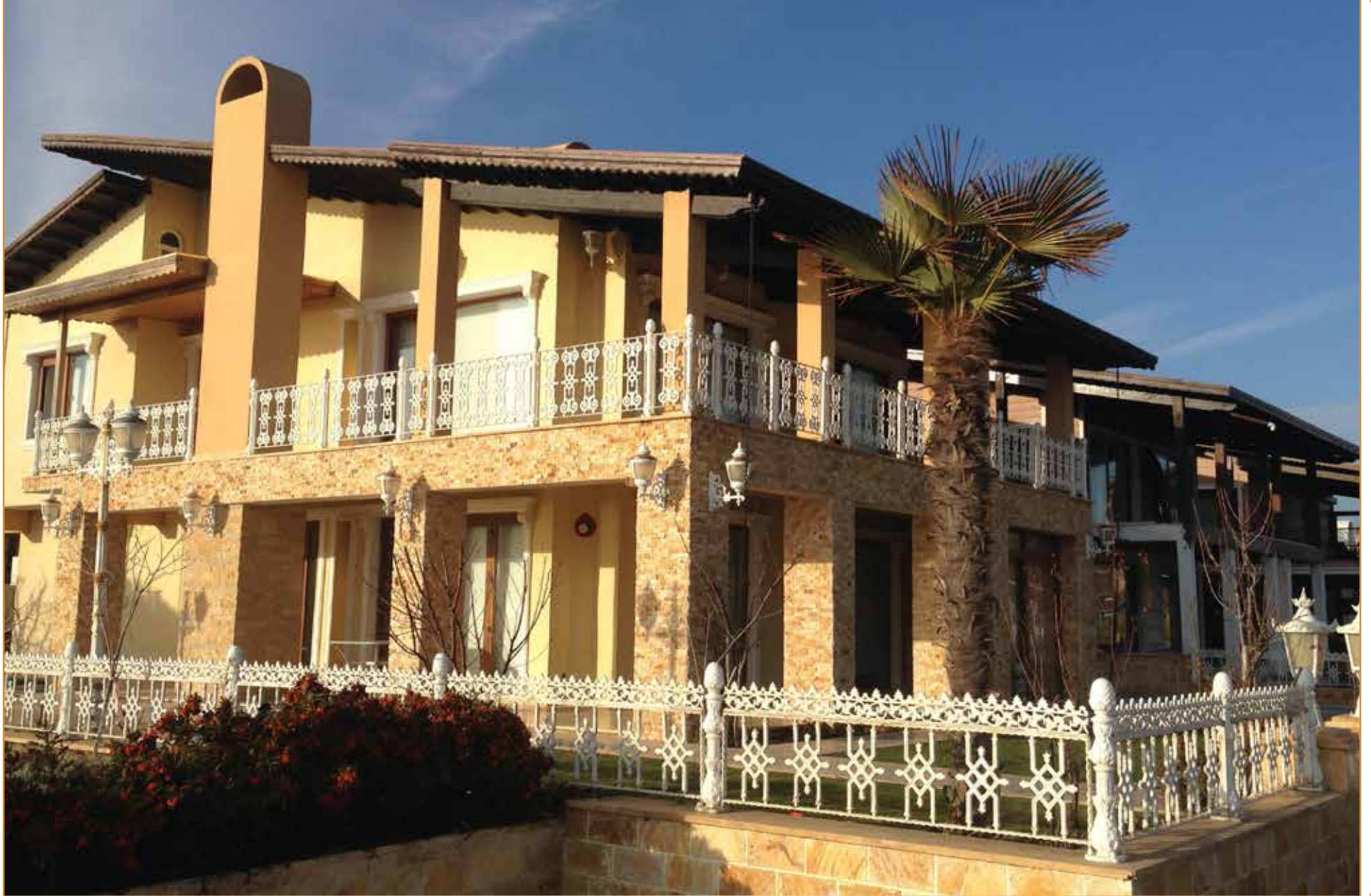
Villa Balkon Korkuluk & Duvar Üzeri Aydınlatma Uygulaması Çeşme / İzmir
