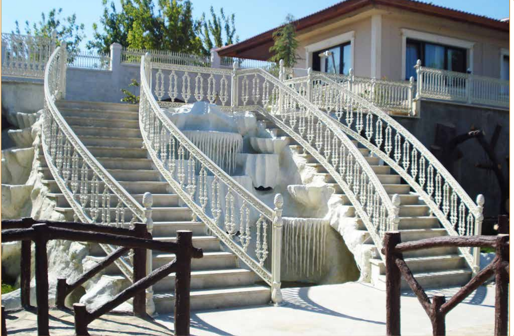
Villa Merdiven Korkuluk Uygulaması Tepekent / İstanbul
