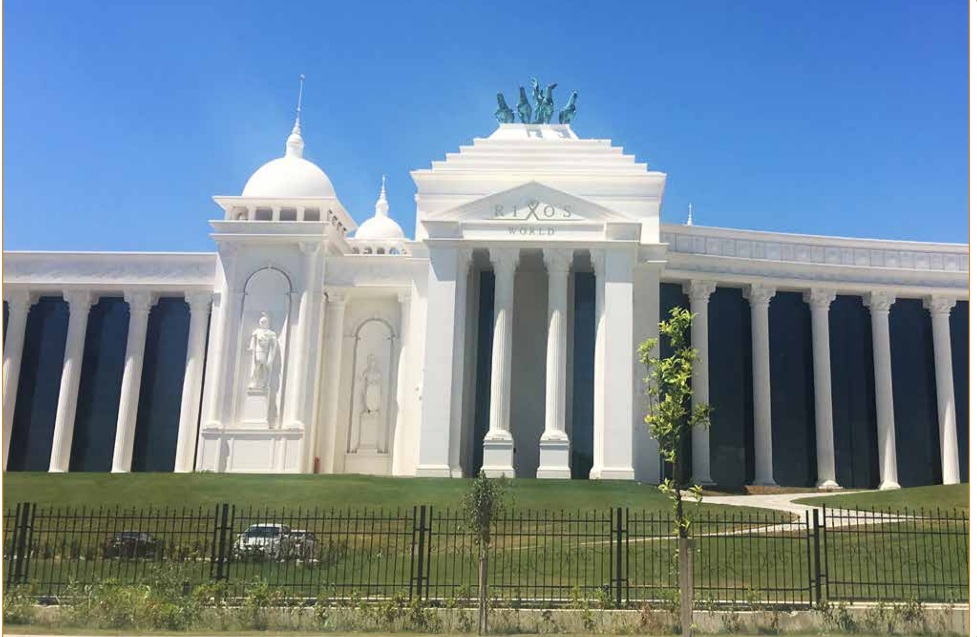
Rixos Hotel Bahçe Duvar Üzeri Ferforje Korkuluk Uygulaması The Land Of Legends Theme Park Belek / Antalya
