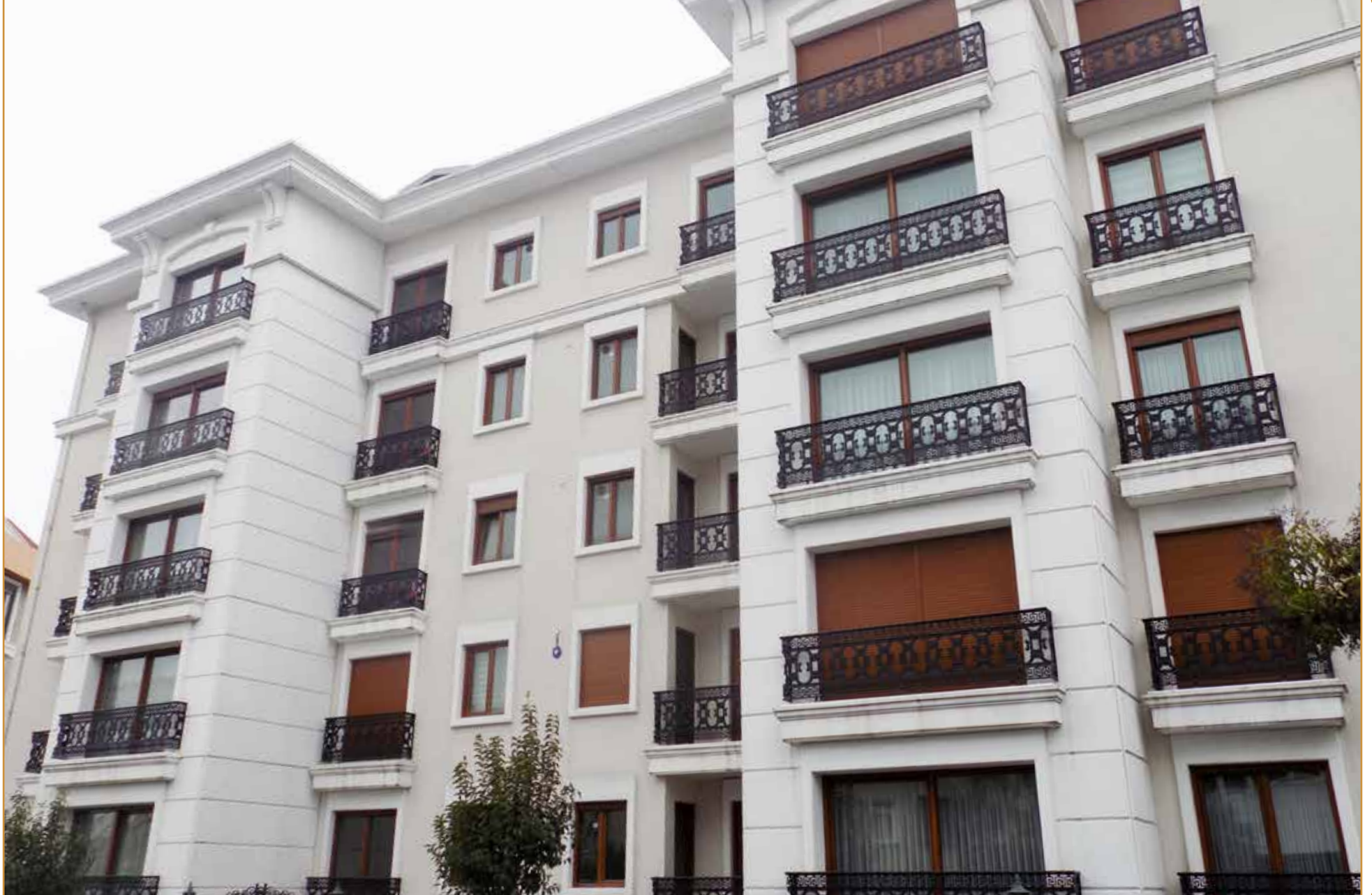
Fransız Balkon Apartman Uygulaması Şişli/ İstanbul
