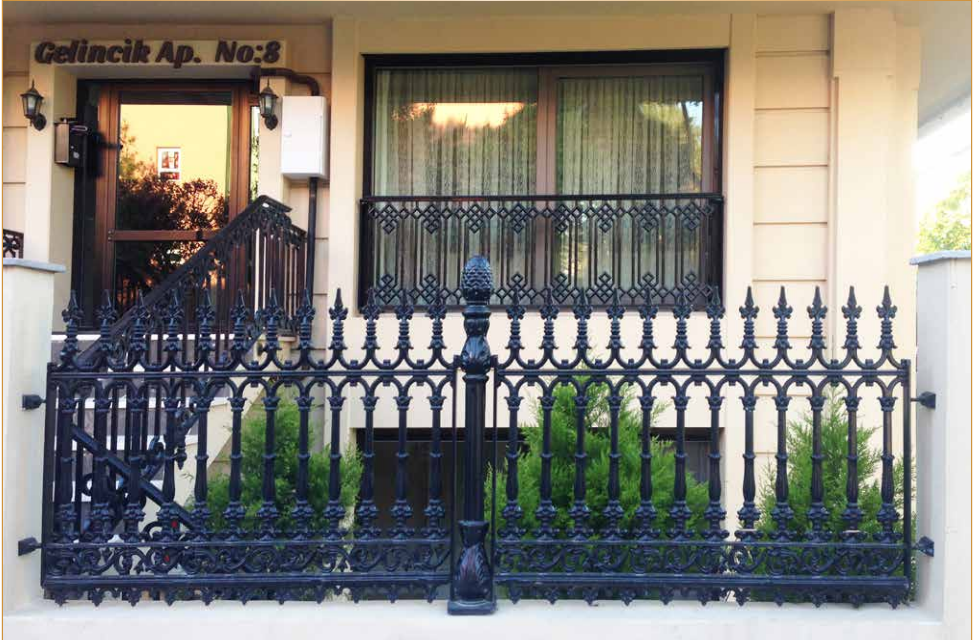
Balkon Merdiven & Duvar Üzeri Korkuluk Uygulaması Yeşilköy / İstanbul
