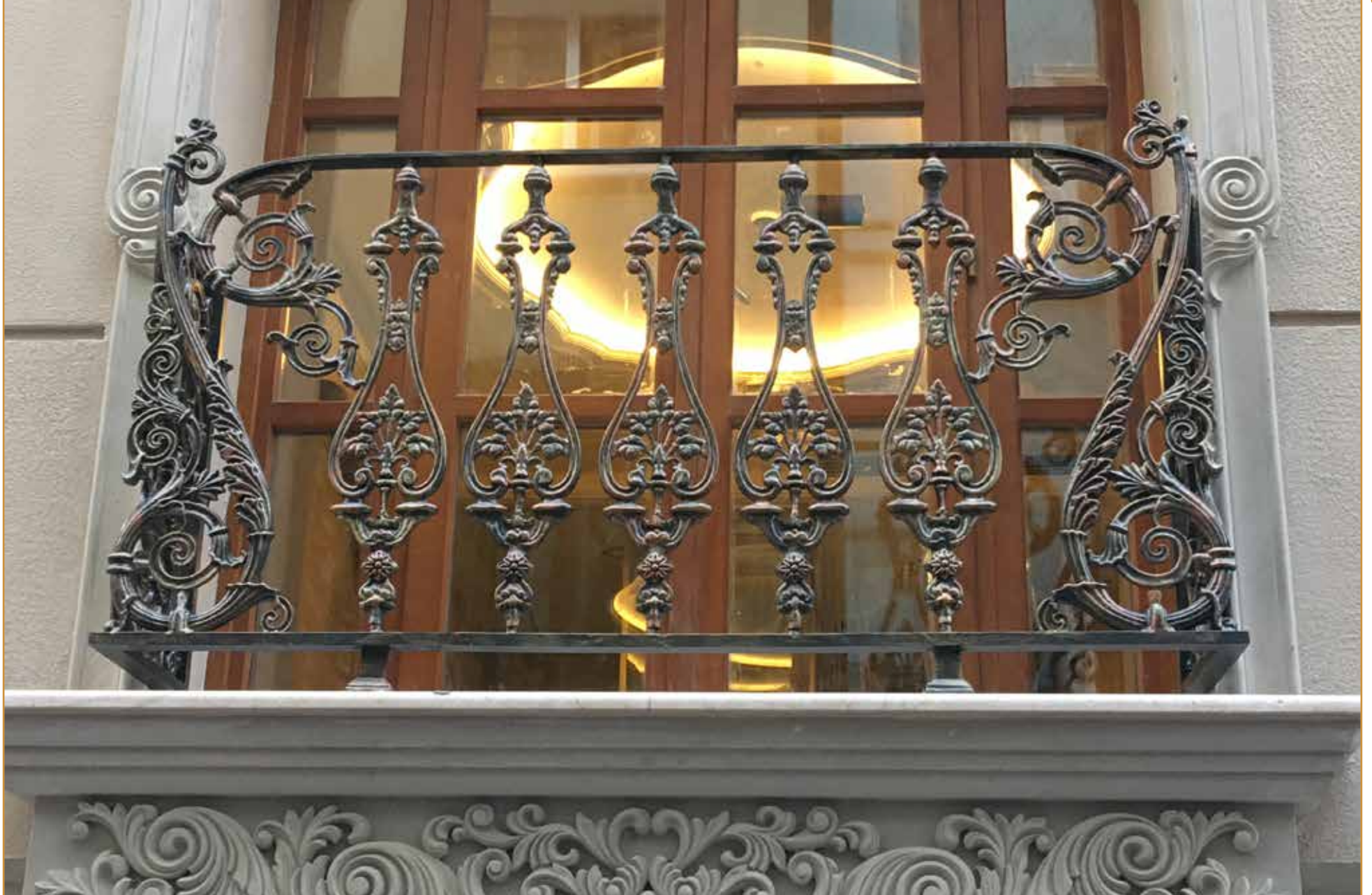
Romance Hotel Ransız Balkon Korkuluk Uygulaması Romance Hotel Sirkeci / İstanbul
