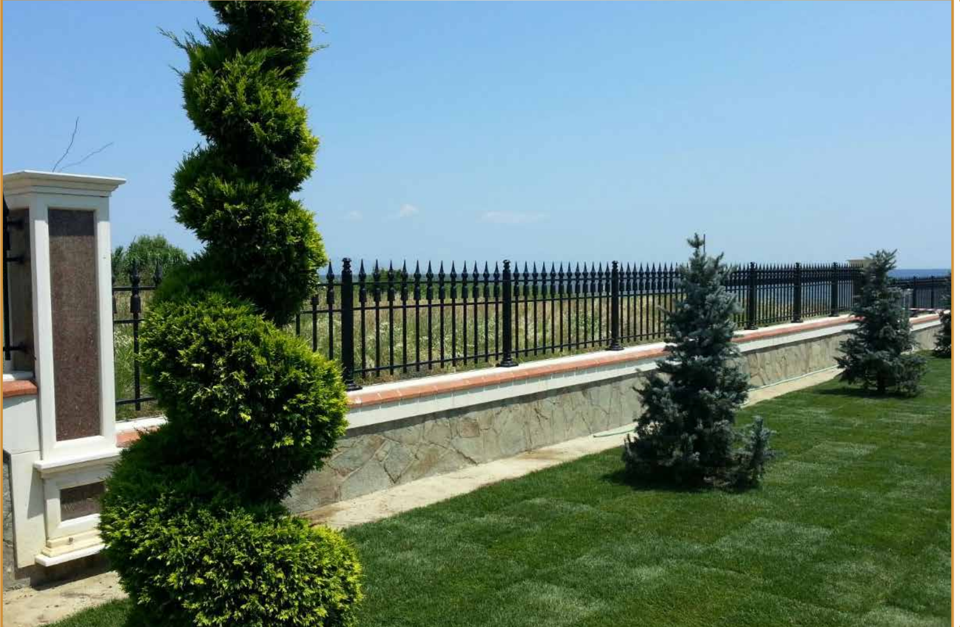
Villa Duvar Üzeri Korkuluk Uygulaması Şarkköy / Tekirdağ
