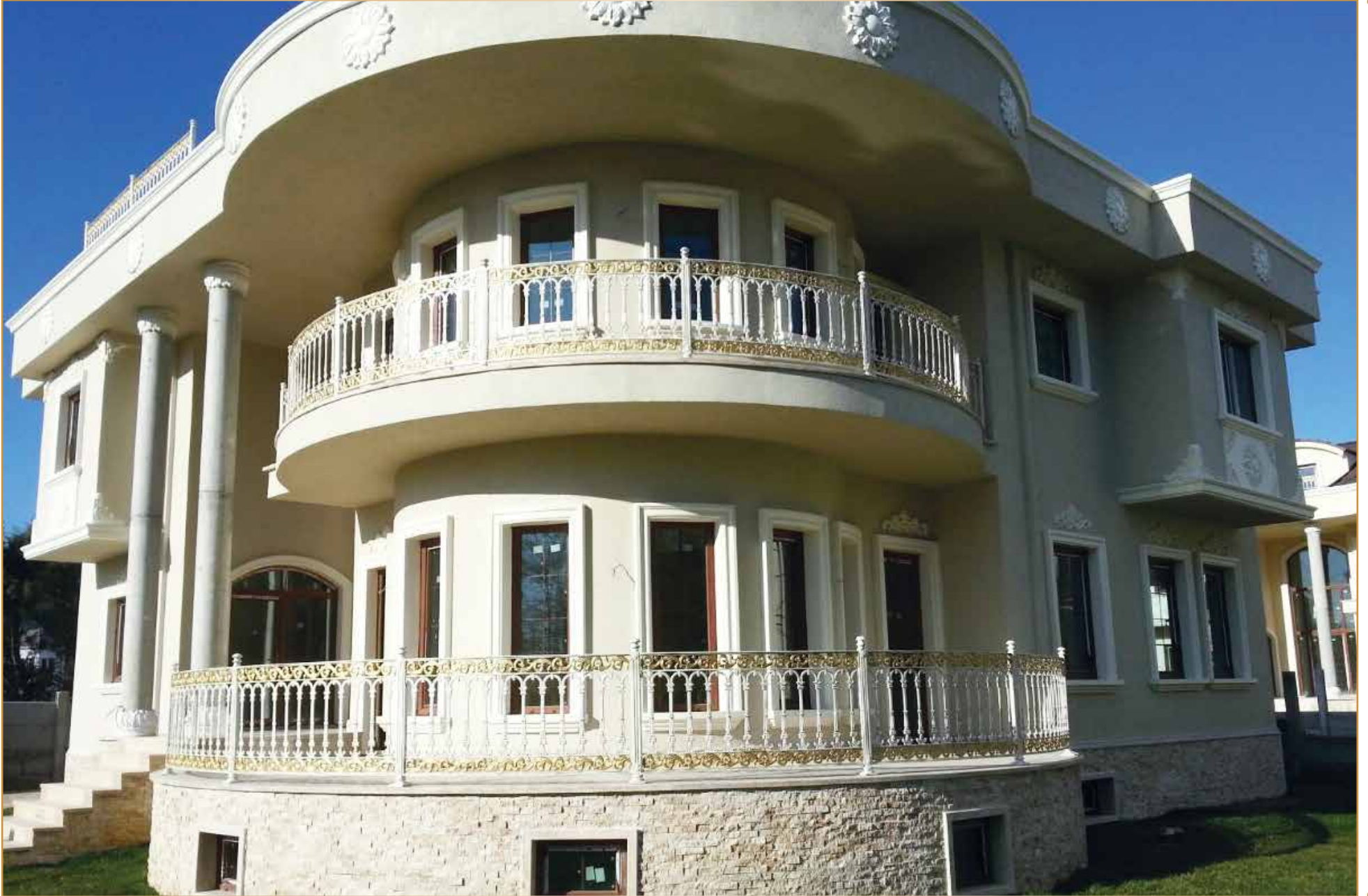
Villa Korkuluk Uygulaması Kemer Country / İstanbul
