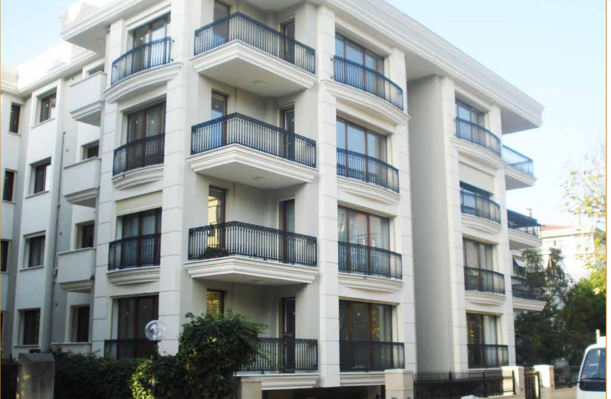
Fransız Balkon & Duvar Üzeri Korkuluk Uygulaması Florya / İstanbul
