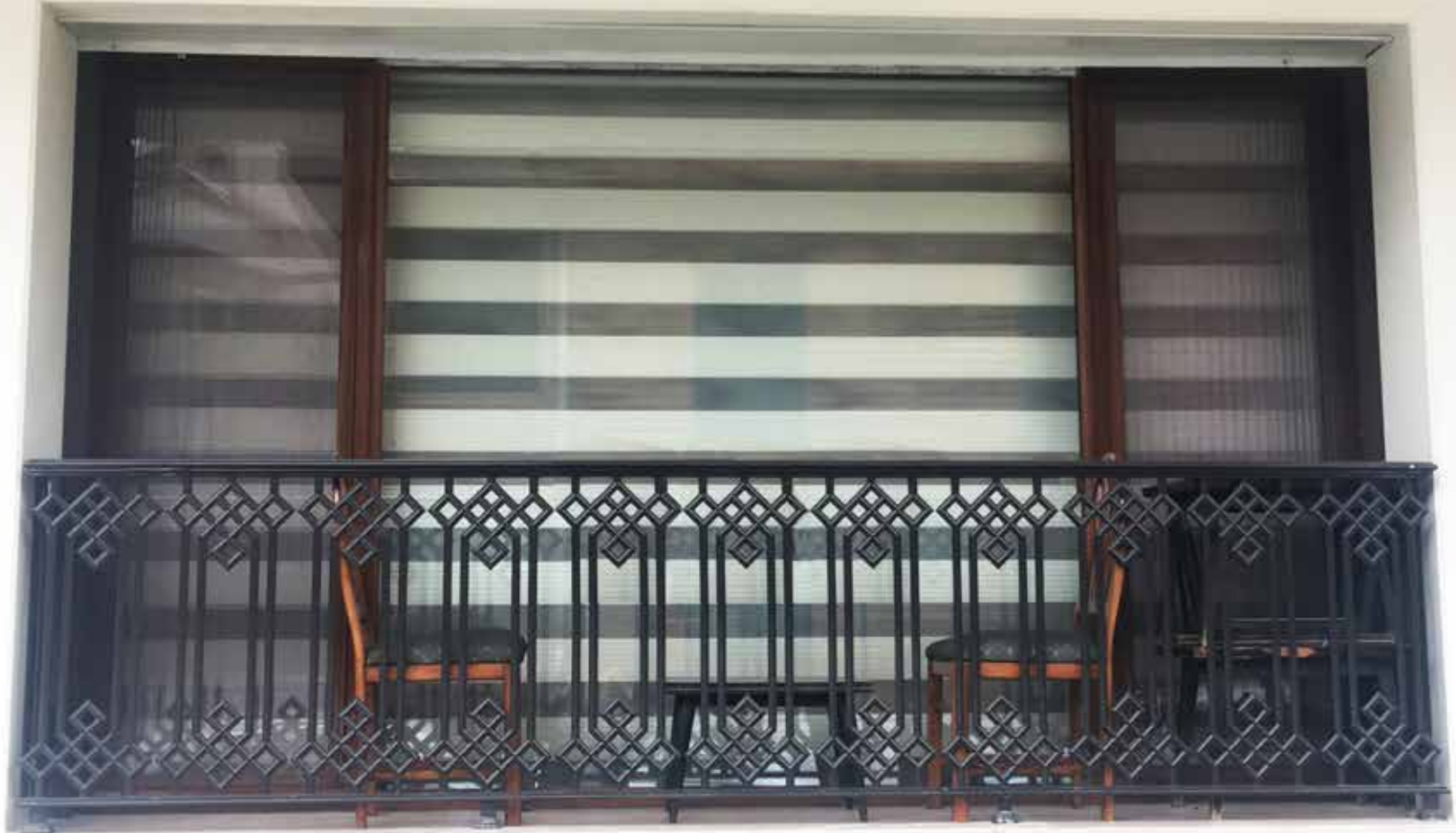
Gül İnşaat Fransız Balkon Uygulaması Yeşilköy / İstanbul
