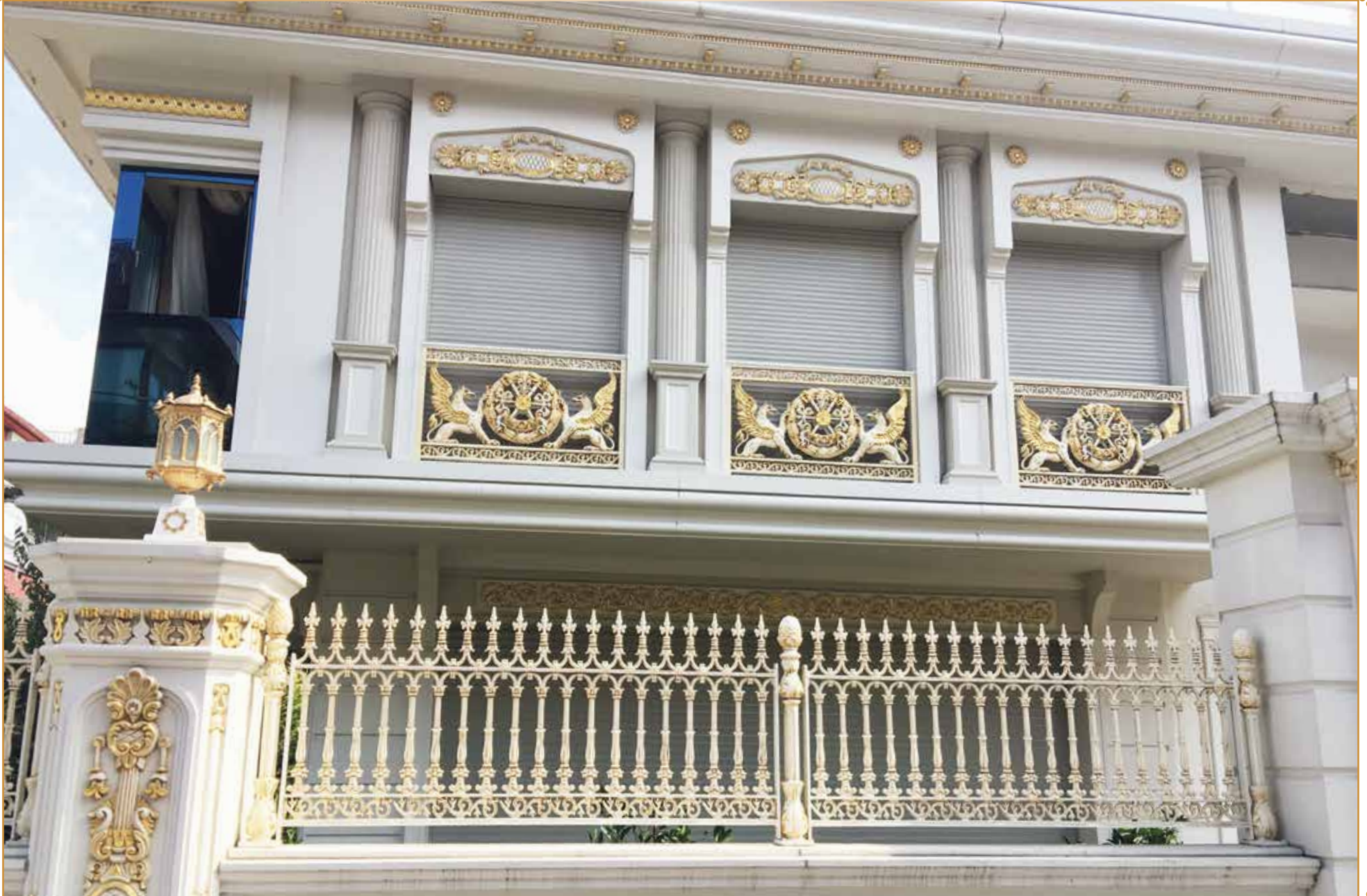
Fransız Balkon & Duvar Üzeri Korkuluk Uygulaması Florya / İstanbul
