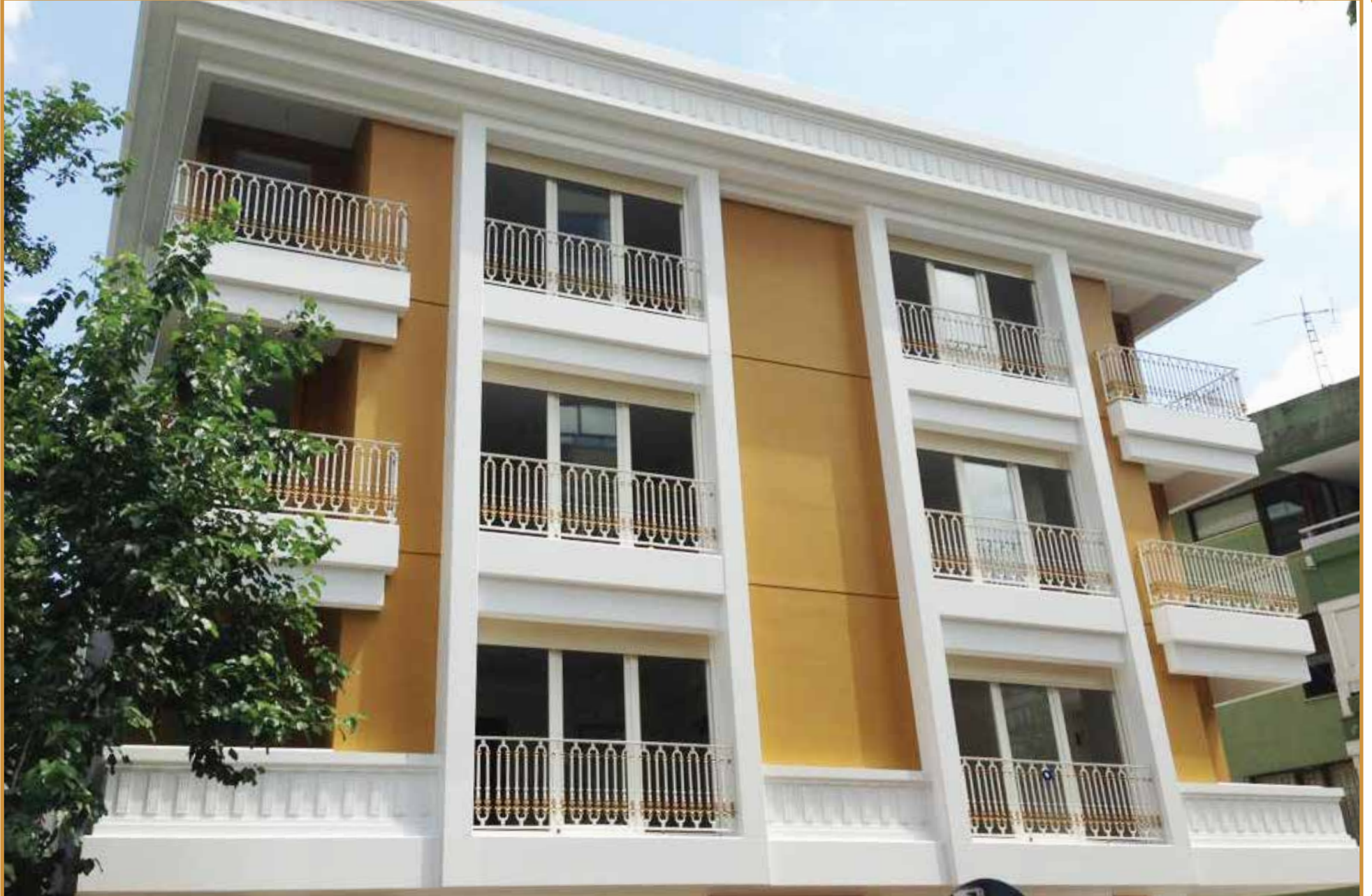
Fransız Korkuluk Uygulaması Kadıköy / İstanbul
