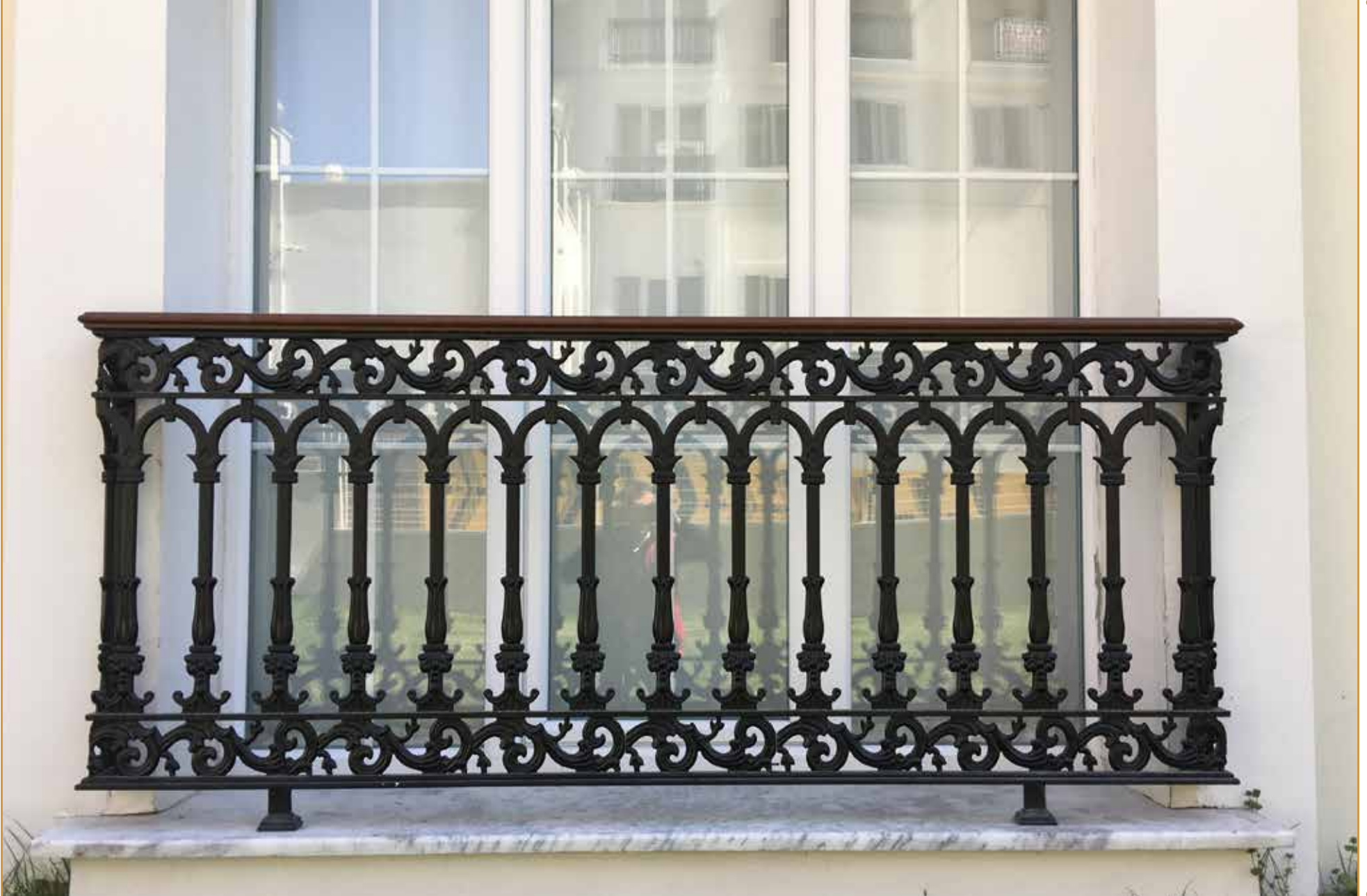
Fransız Balkon Korkuluk Uygulaması Bostancı / İstanbul
