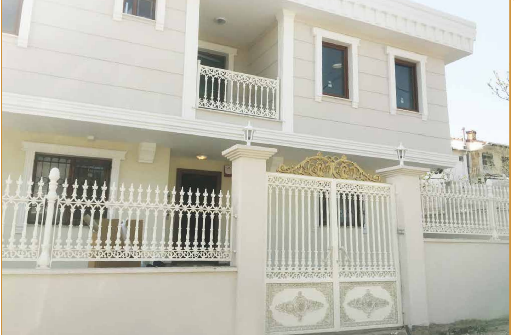
Villa Fransız Kapı & Duvar Üzeri & Balkon Korkuluk Uygulaması Didim / Aydın
