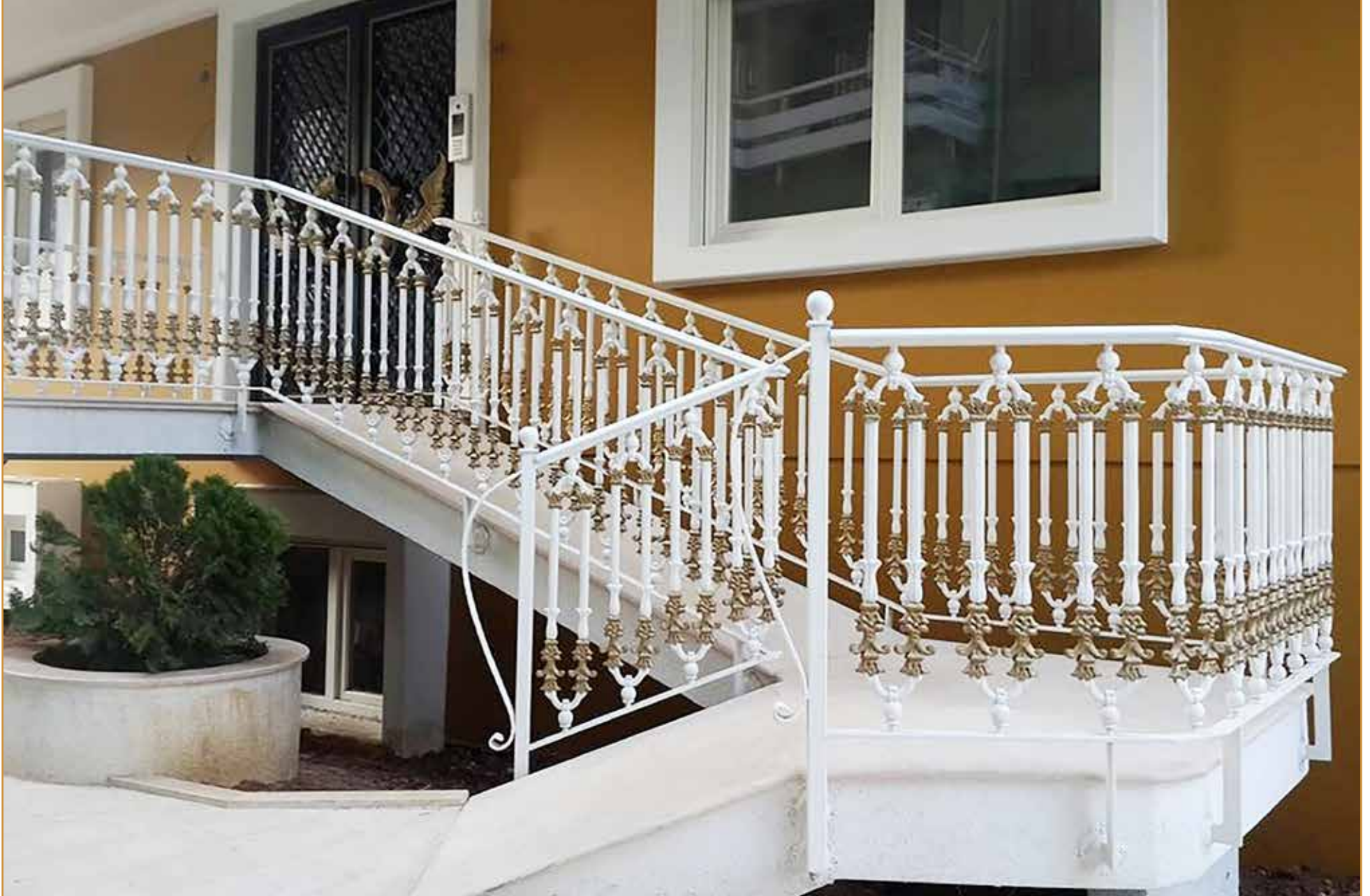
Merdiven Korkuluk Uygulaması Kadıköy / İstanbul
