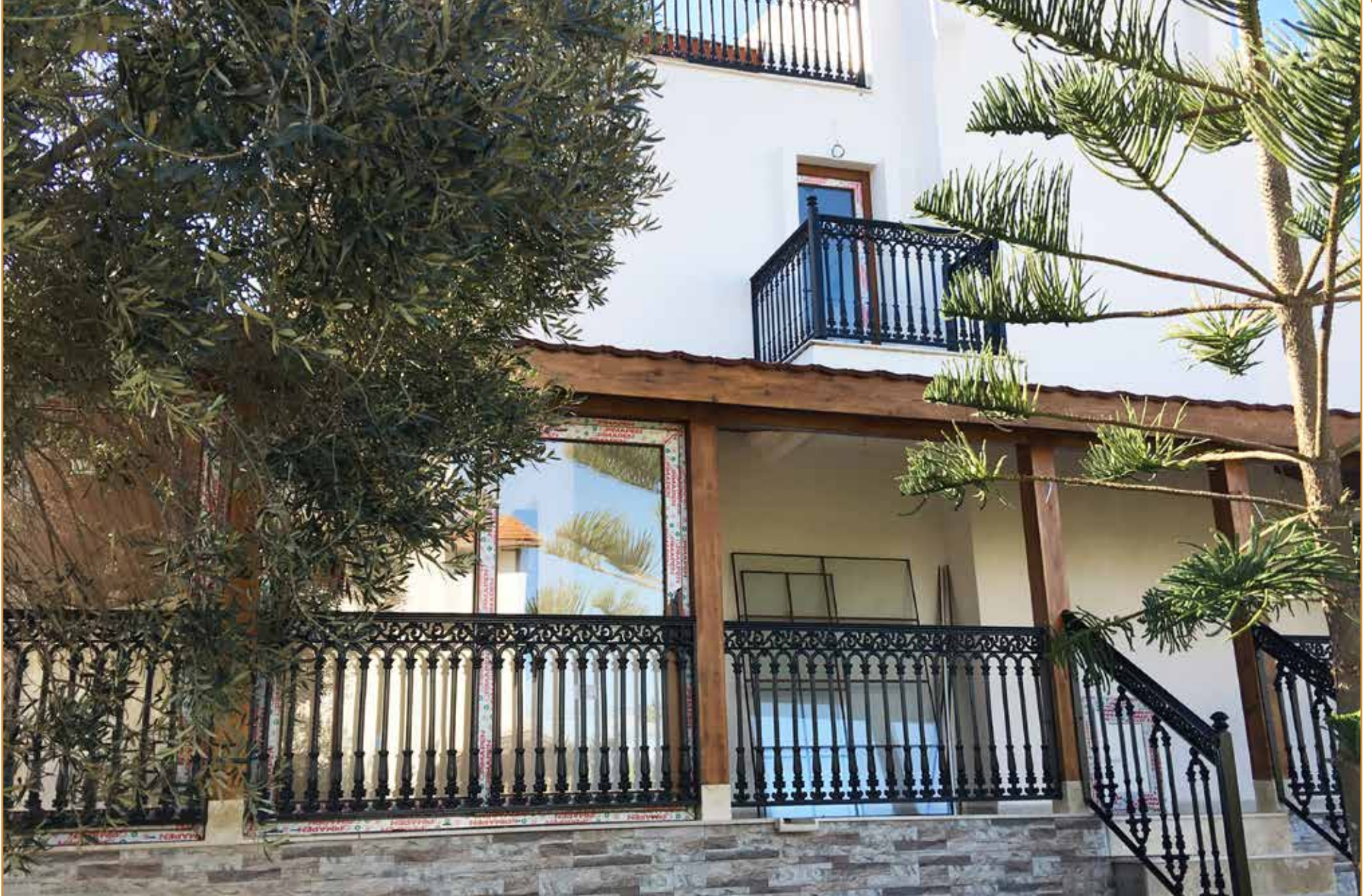
Villa Balkon & Merdiven Uygulaması Datça/ Muğla
