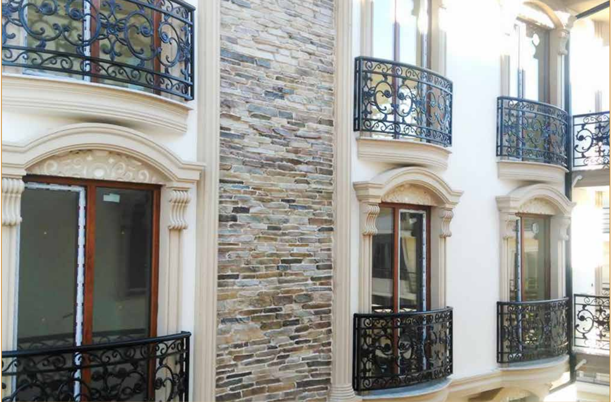
Fransız Balkon Korkuluk Uygulaması
