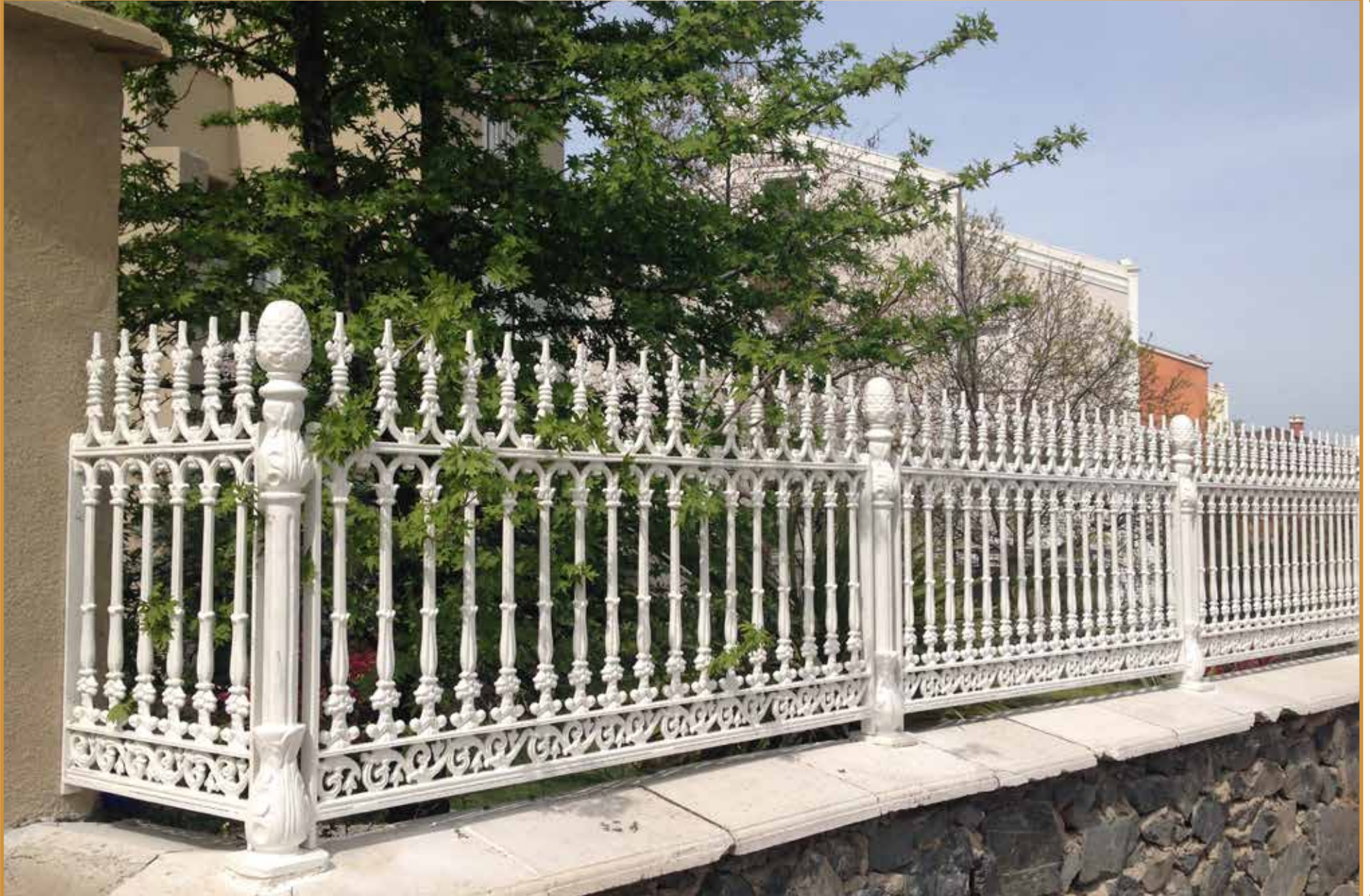
Duvar Üzeri Korkuluk Uygulaması Zekeryaköy / İstanbul
