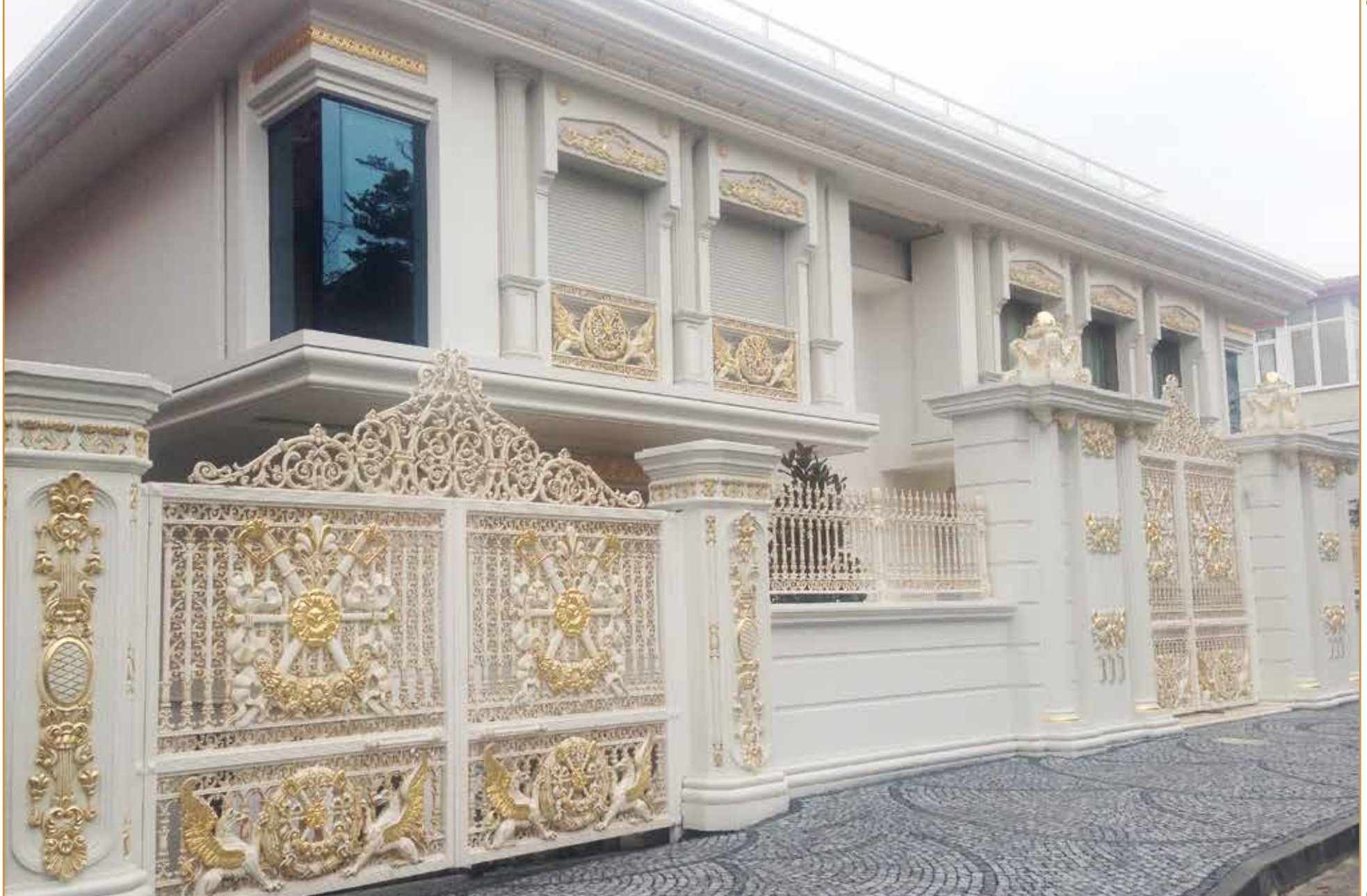
Fransız Balkon & Kapı Uygulaması Florya / İstanbul
