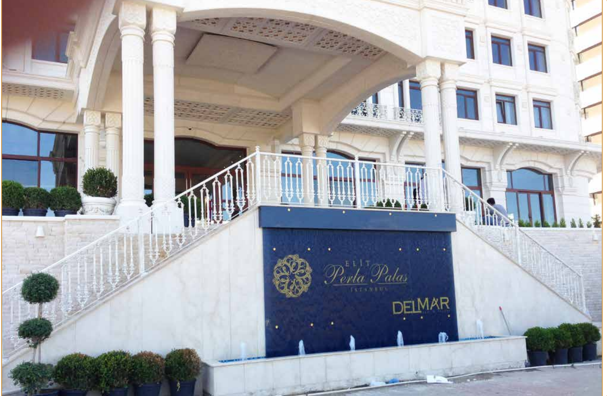
Elit Perla Palas Fransız Balkon & Merdiven Uygulaması Kurtköy / İstanbul
