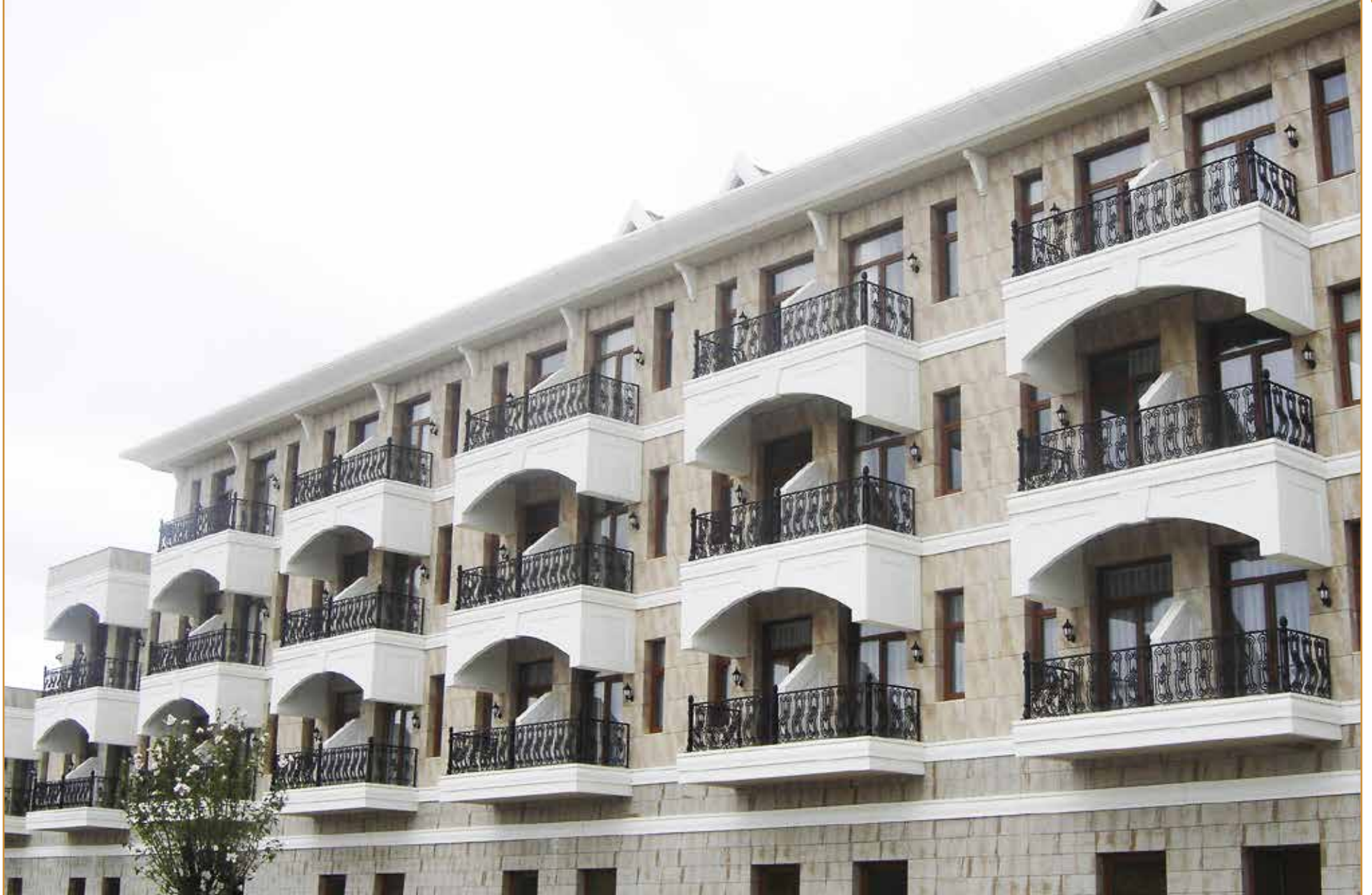
Best Western Gardens Hotel Balkon Korkuluk Uygulaması Şile / İstanbul
