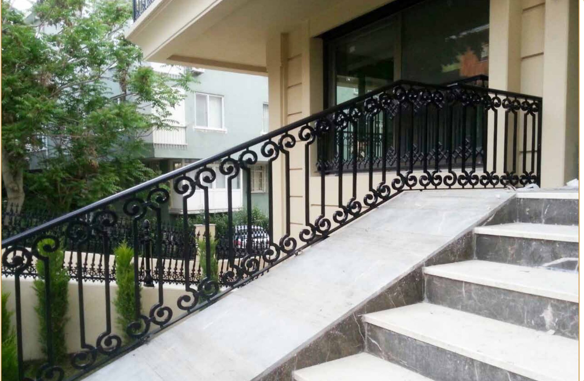
Merdiven Korkuluk Uygulaması Yeşilyurt / İstanbul
