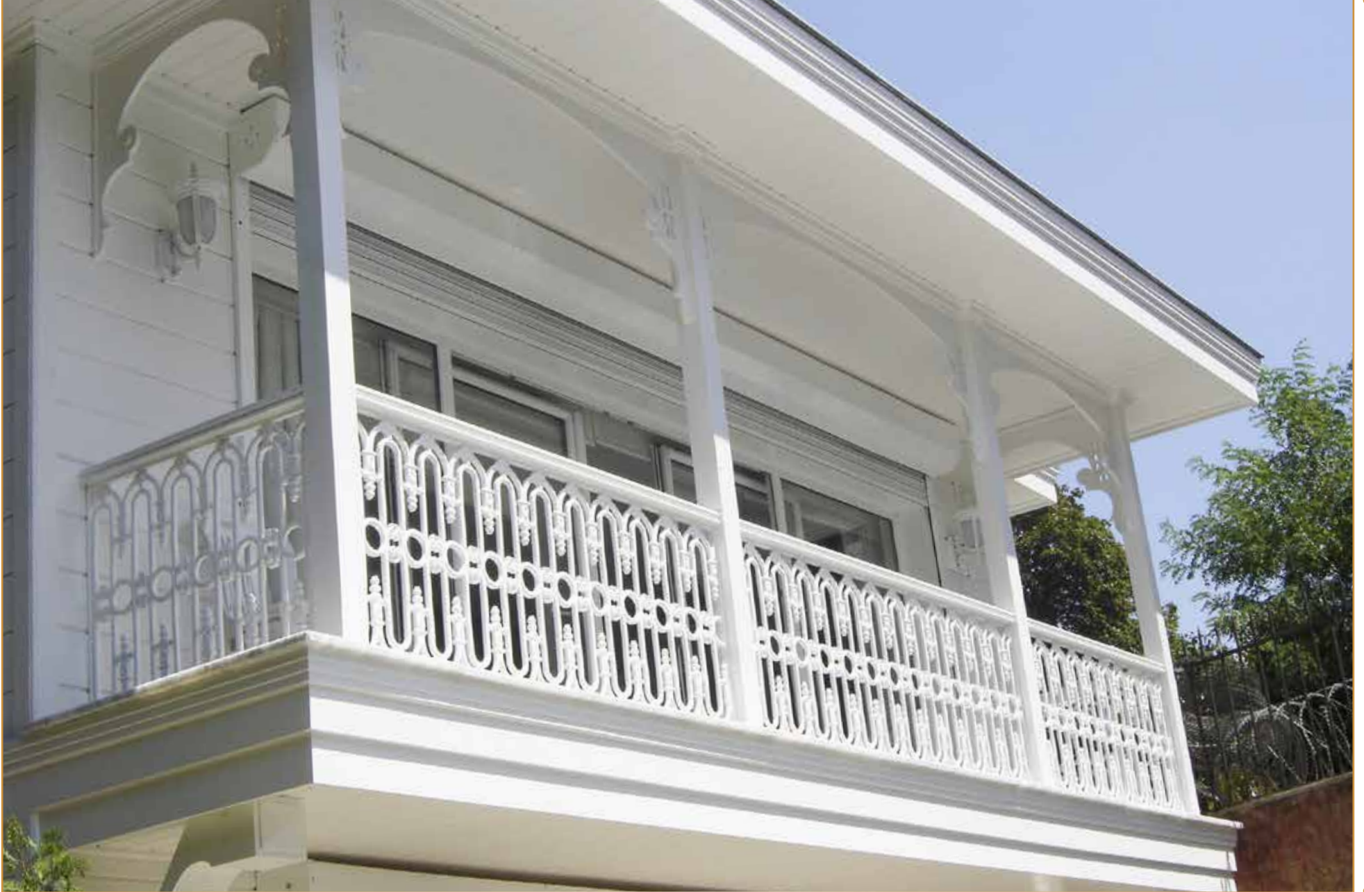
Balkon Korkuluk Uygulaması Sarıyer /İstanbul
