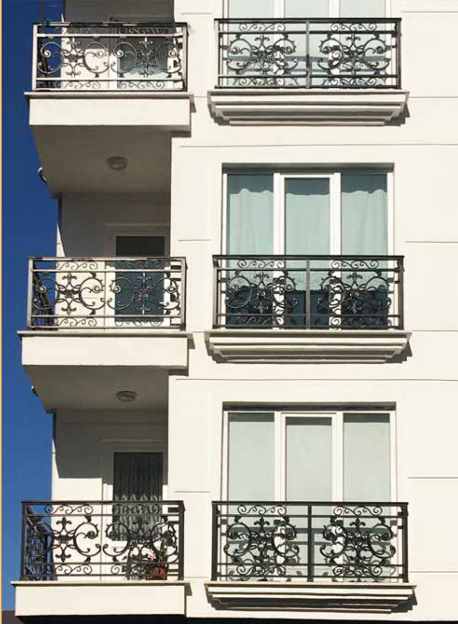
Fransız Balkon & Otel Uygulaması Lüleburgaz / Kırklareli
