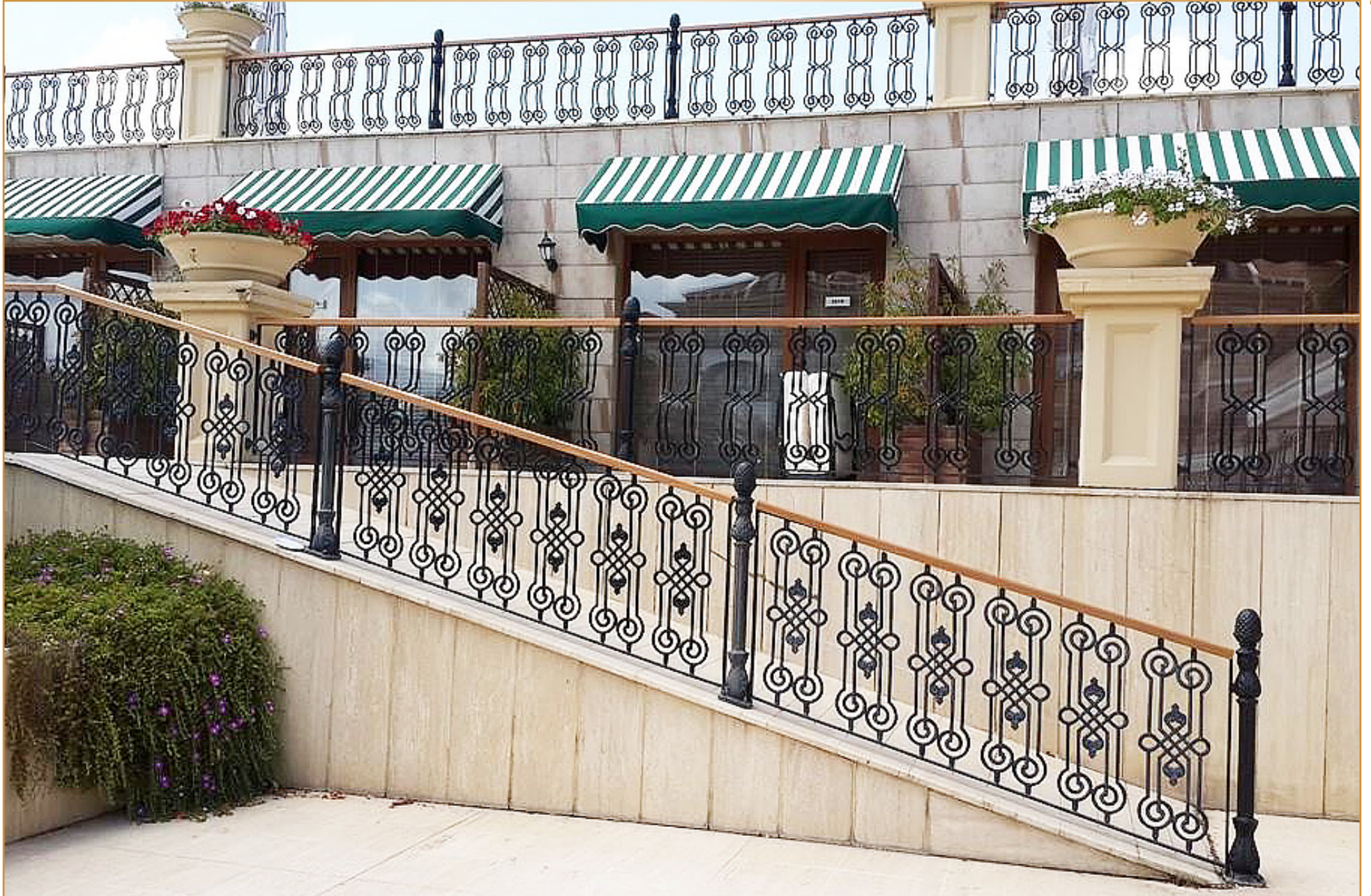
Best Western Gardens Hotel Merdiven & Balkon Korkuluk Uygulaması Şile/ İstanbul
