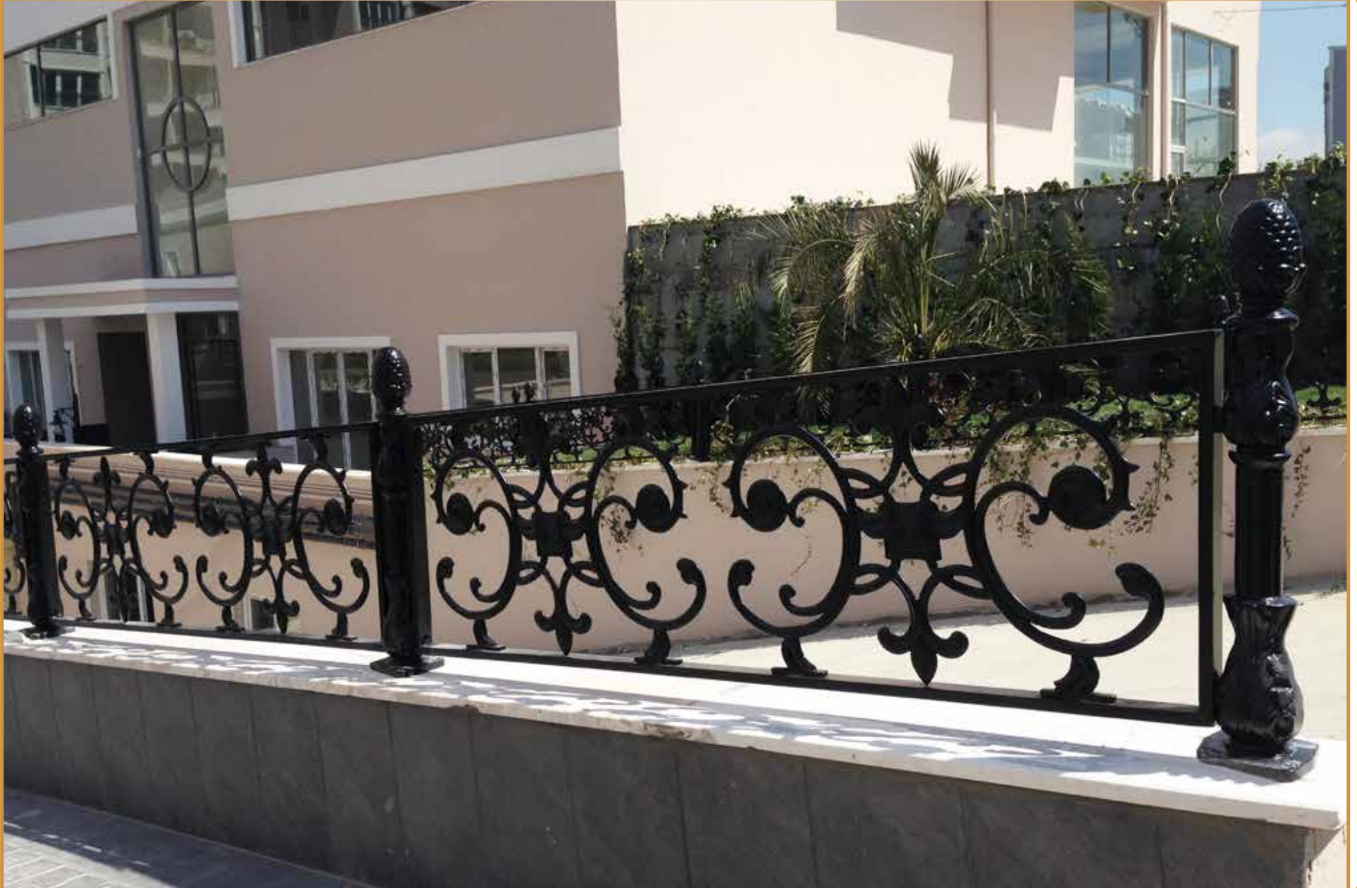
Gül İnşaat Duvar Üzeri Korkuluk Uygulaması İstanbul
