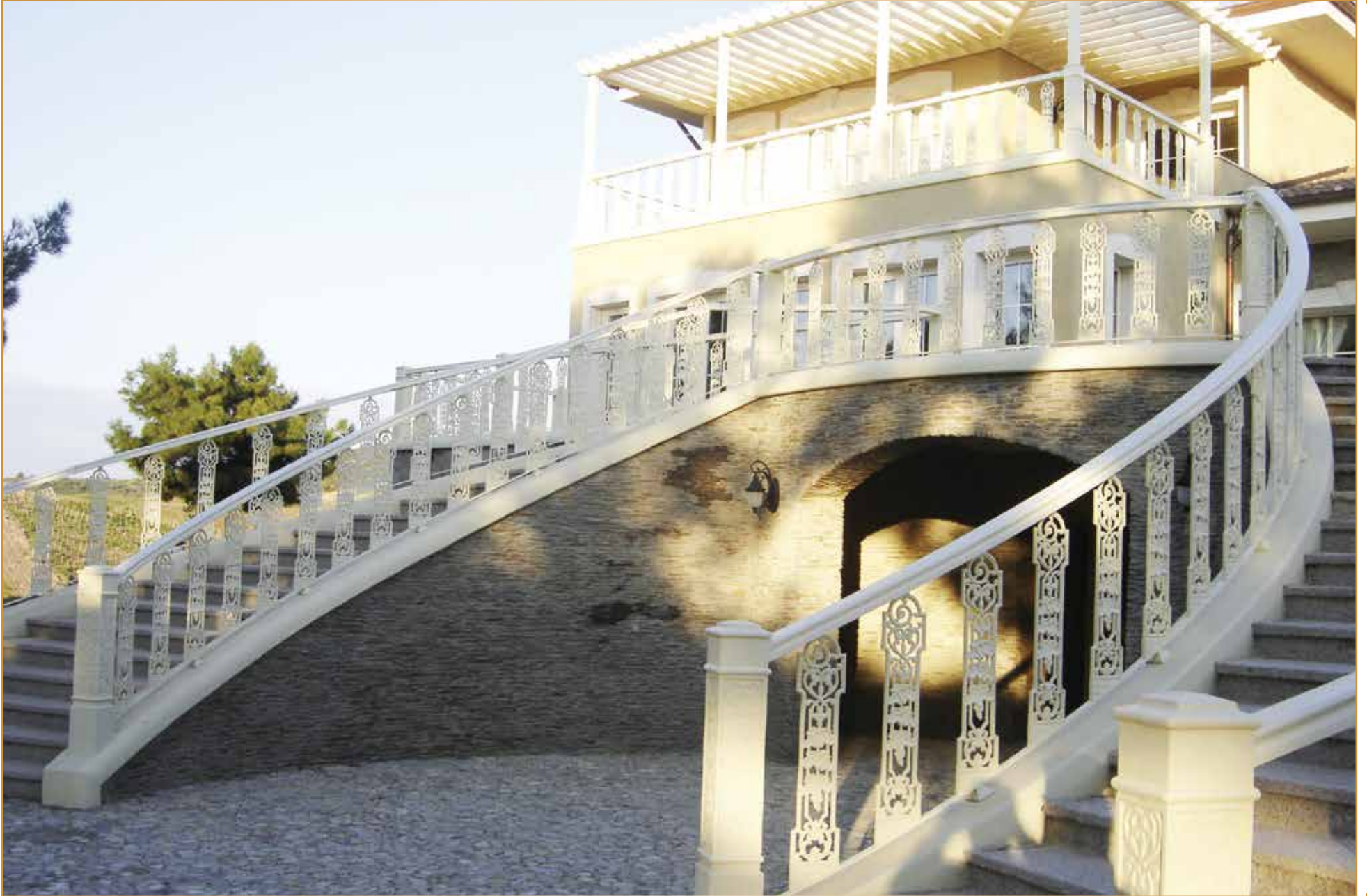
Bağ Evi Korkuluk Uygulaması Bakü / Azerbaycan
