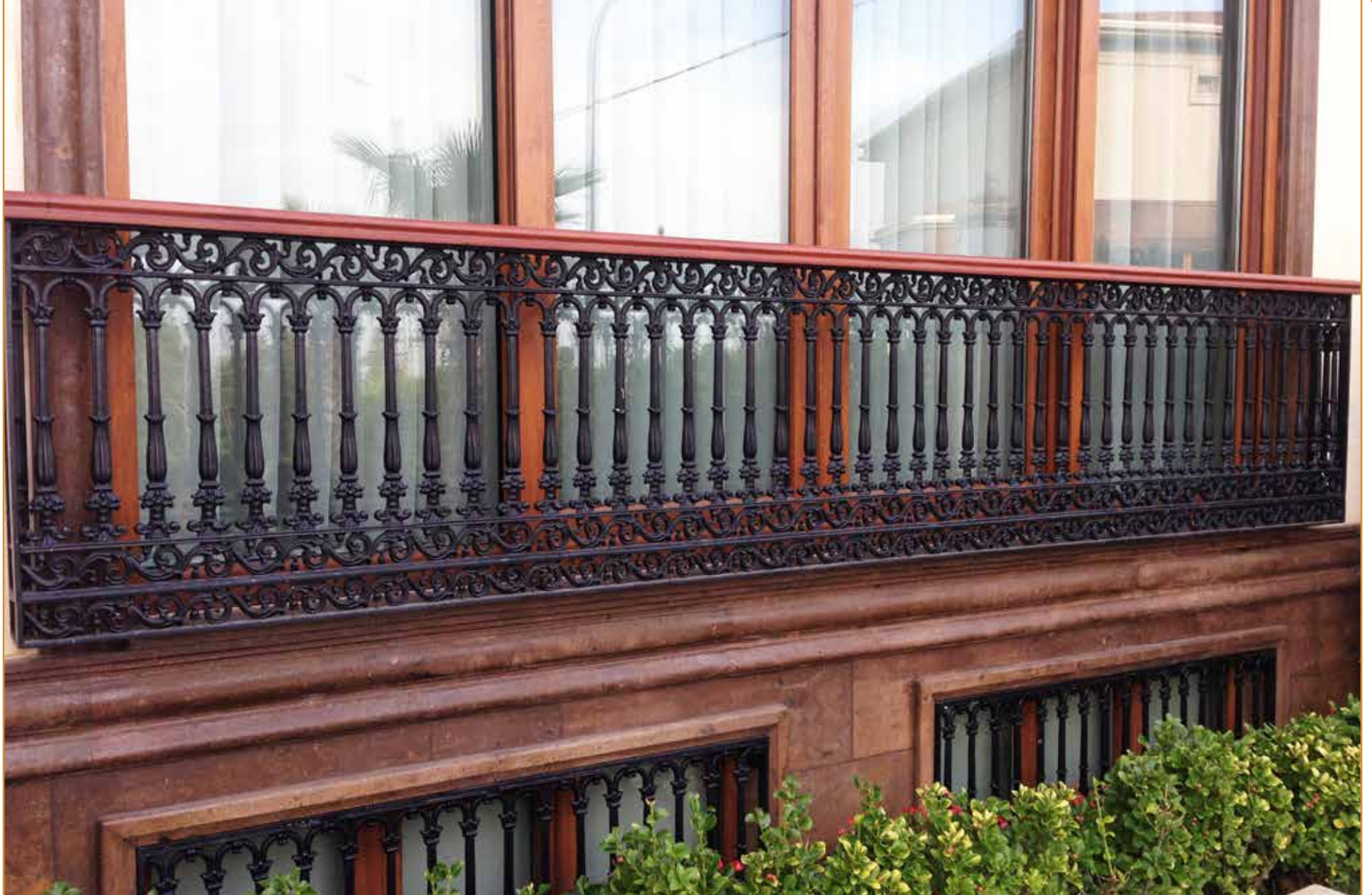
Villa Balkon Korkuluk Uygulaması Kandilli / İstanbul
