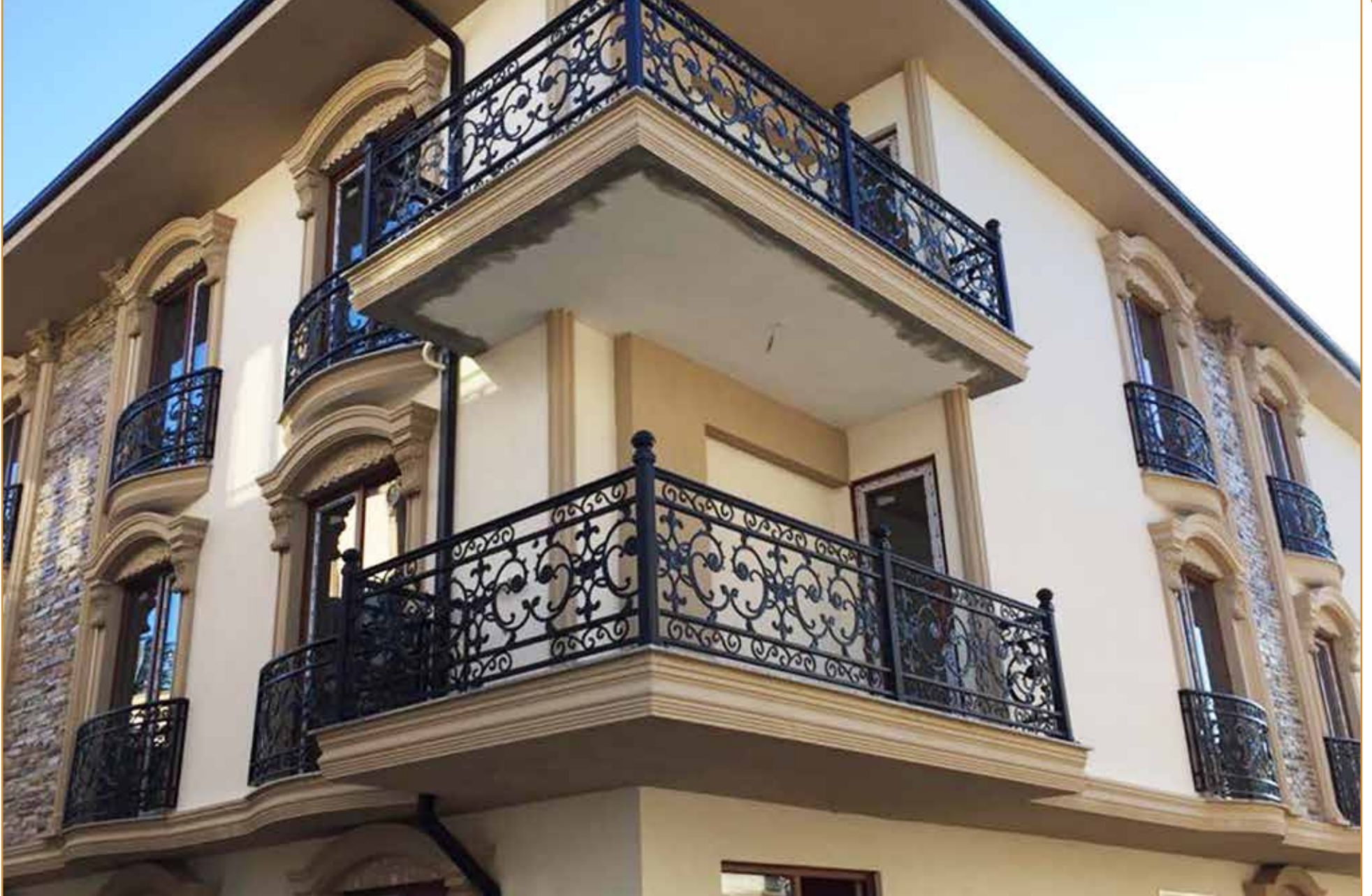
Fransız Balkon Korkuluk Uygulaması
