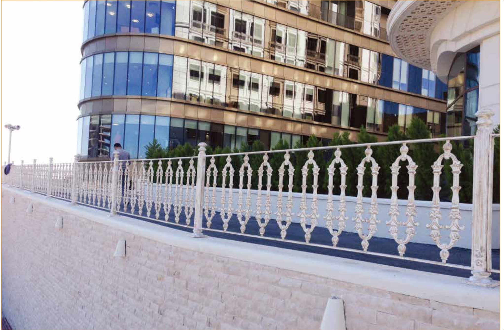
Elit Perla Palas Duvar Üzeri Korkuluk Uygulaması Kurtköy / İstanbul
