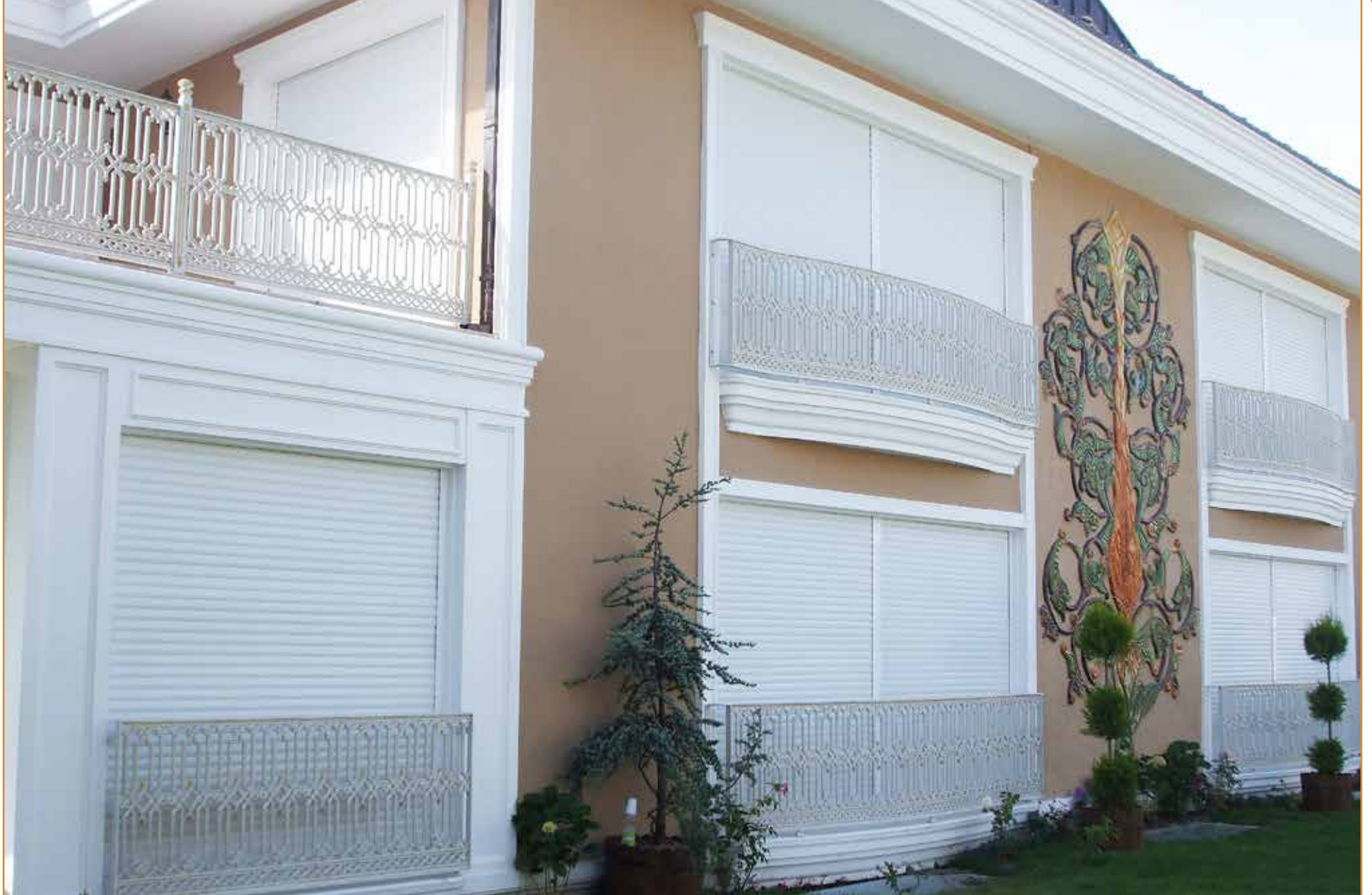
Sahinler Giyim Villa Balkon Korkuluk Uygulaması Kemerburgaz / İstanbul
