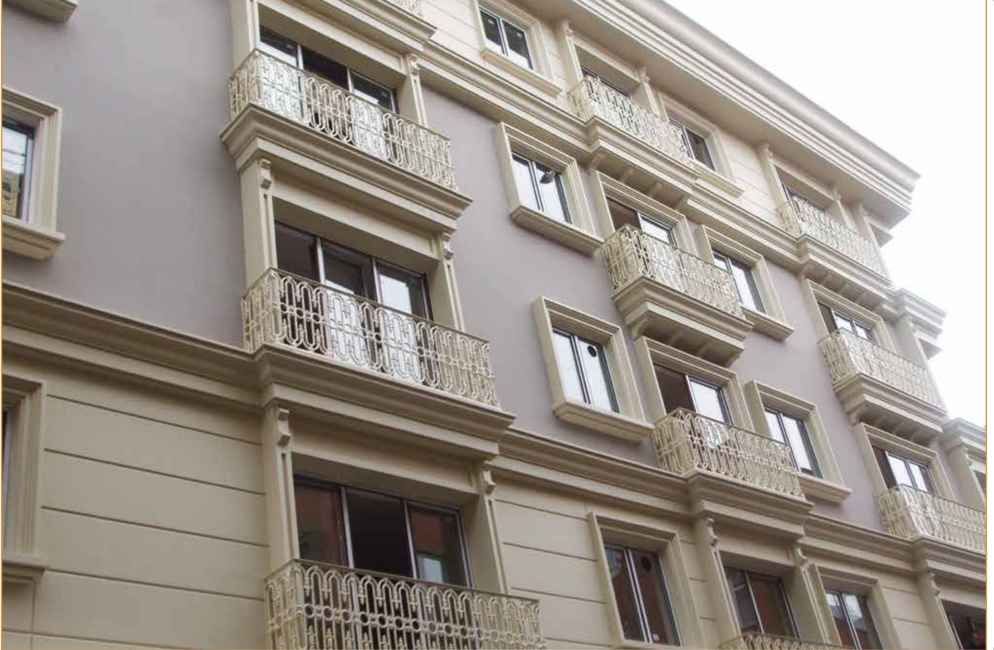
Apartman Balkon Korkuluk Uygulaması Şişli / İstanbul
