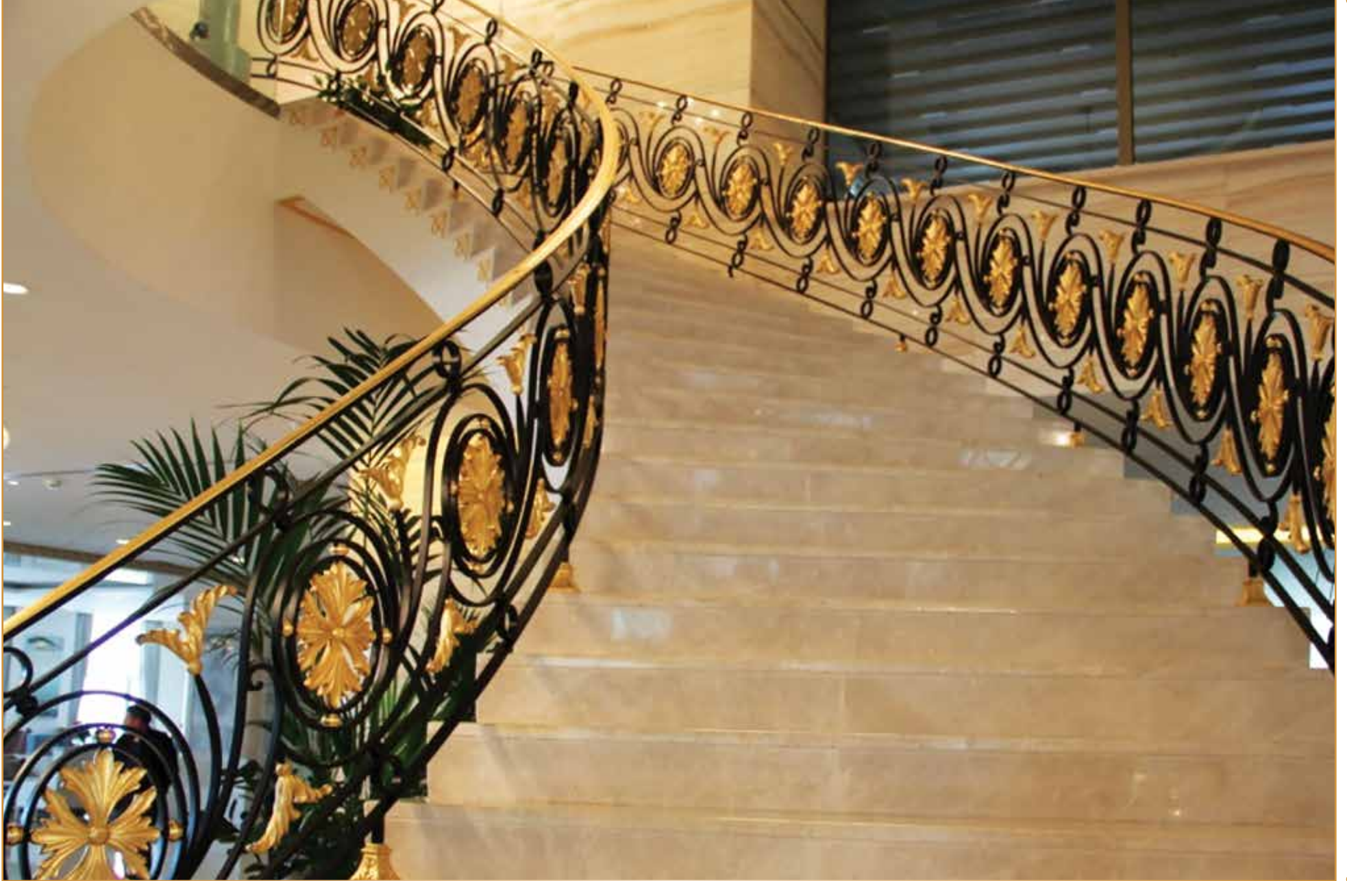
Villa Merdiven Korkuluk Uygulaması Erbil / Irak
